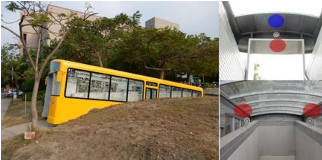
紅色為光源設置位置 藍色為配電箱設置位置(車體入口框架上方)
