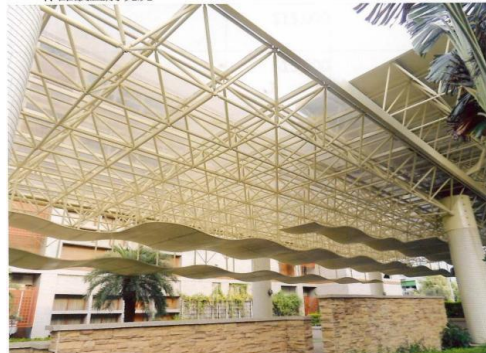
● 作品設置前現況
